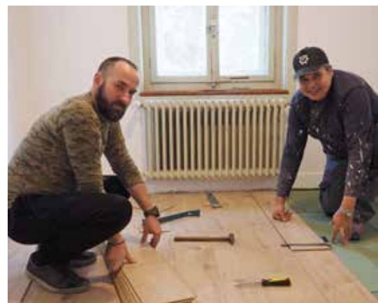
Unter Anleitung von Martin Sigrist werden die Laminatböden fachgerecht verlegt
