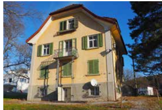
Das Haus an der Kemptnerstrasse 8
