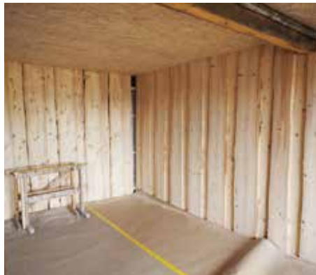
Ein Blick in den umgebauten Stall
