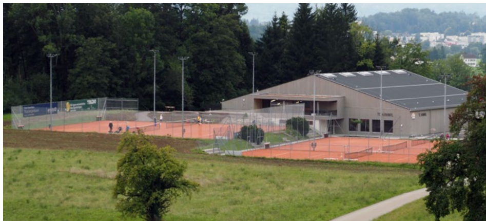
Die Halle mit der Holzfassade fügt sich harmonisch in die bestehende Anlage und die Umgebung ein.
